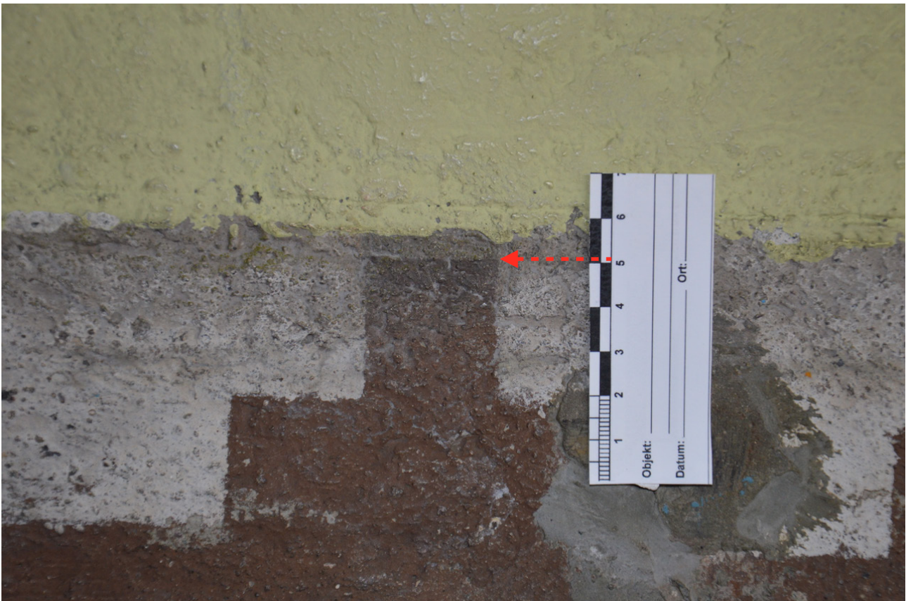
Sockelbereich: brauner Sockelstreifen, gut sichtbares Ende auf der Mitte des horizontalen Kreuzbalkens
