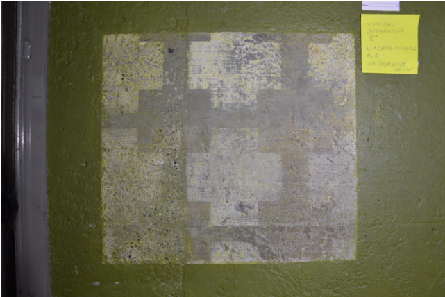
Ostwand: Abgeschlossene Freilegung. Der Rapport der Kreuze ist klar ersichtlich. Die Grundfarbe der Wand ist deckend gestrichen (braun-violett) und nicht, wie an den Längswänden, lasierend aufgetragen.
