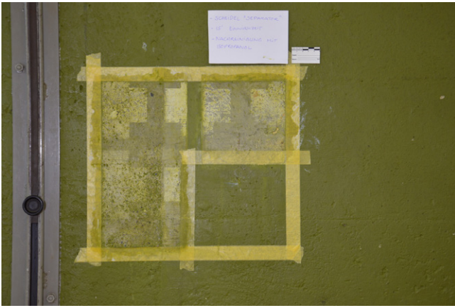
Ostwand: Während der Freilegung. In der rauhen Struktur des Abriebs auf der linken Seite verbleiben unzählige Farbresten in den Tiefen.
